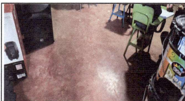
FOTO 5: Sustitución de piso cerámico
