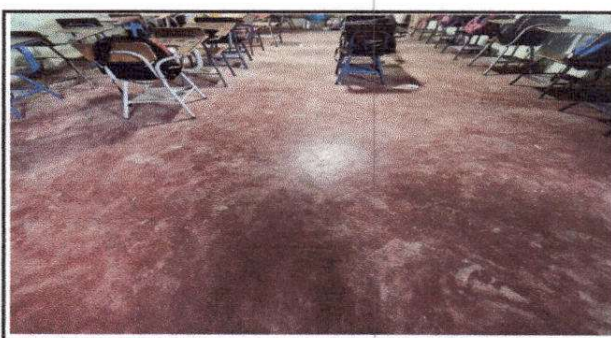
FOTO 6: Sustitución de piso cerámico
