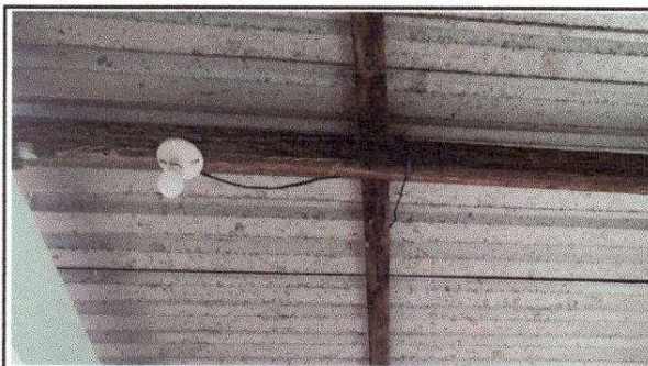
FOTO 9: Sustitución de focos ahorradores
