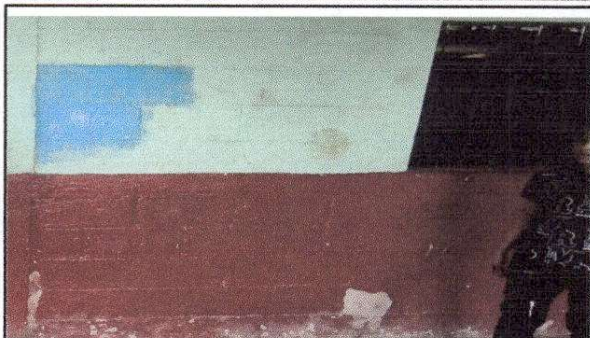
FOTO 7: Pintura en muros exteriores e interiores
